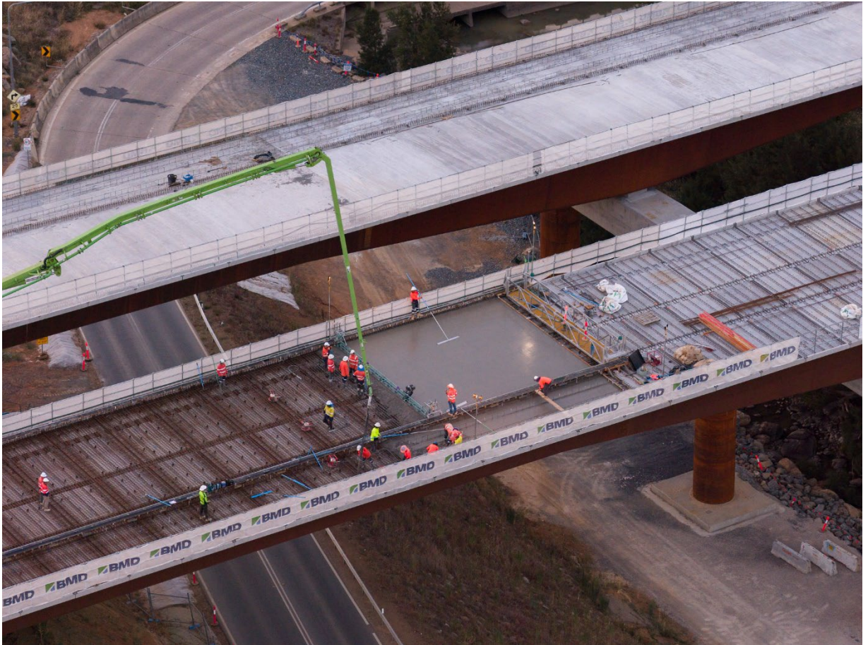
Molonglo River Bridge – Concrete pour
